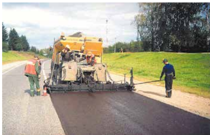
Рис. 8. Смеситель-укладчик AkzoNobel HD-10, РУП «Гомельавтодор»
