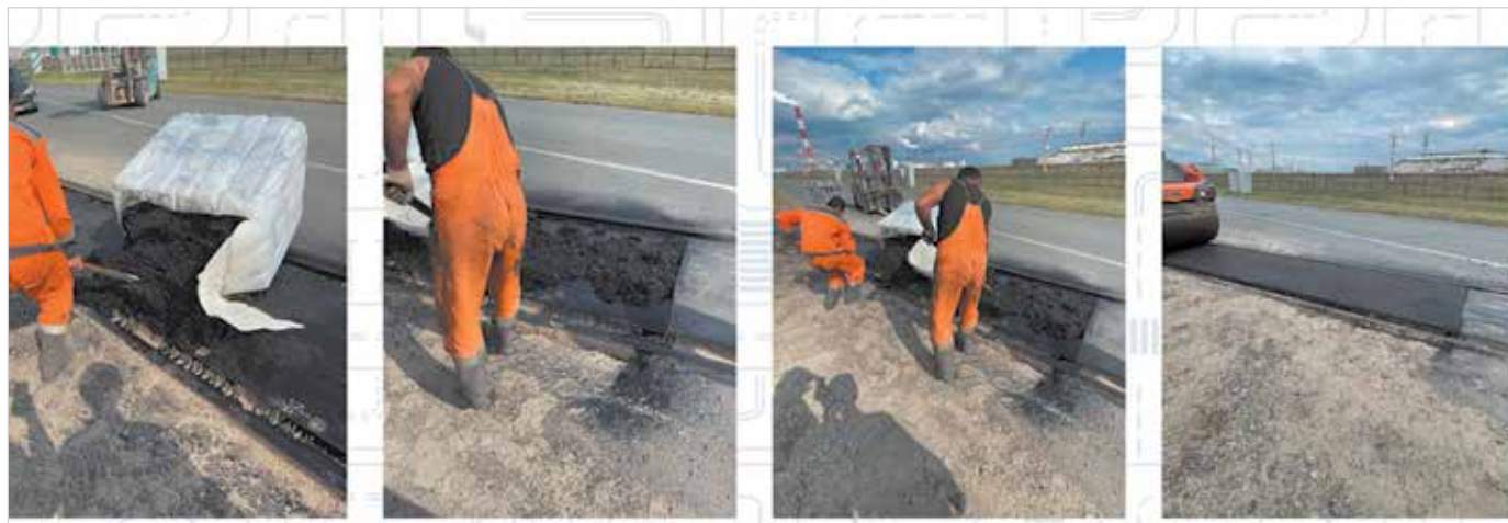
Рис. 3. Укладка холодной гранулированной смеси в III дорожно-климатической зоне
