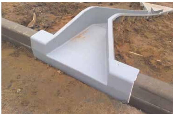
Монтаж системы можно производить вручную. Исключается риск сползания лотков по откосам высоких насыпей, поэтому длина лотка на откосе не ограничена
