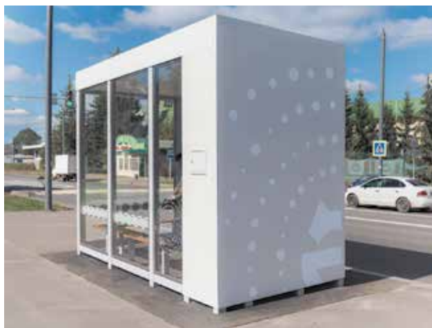
Модульная система собирается как конструктор, упрощая монтаж и позволяя адаптировать размеры под любую площадку
