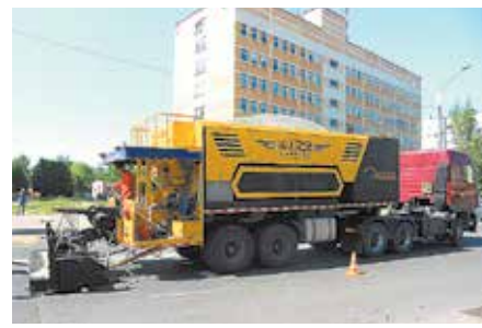
Рис. 6. Смеситель-укладчик Fiber Slurry Paver, государственное предприятие «Гордорматериалы»
