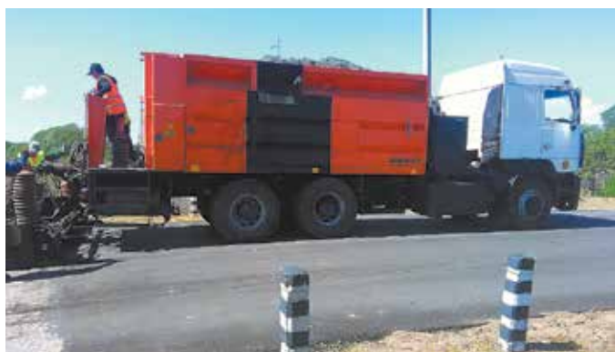
Рис. 2. Смеситель-укладчик Bergkamp M210, КУП «Гроднооблдорстрой»
