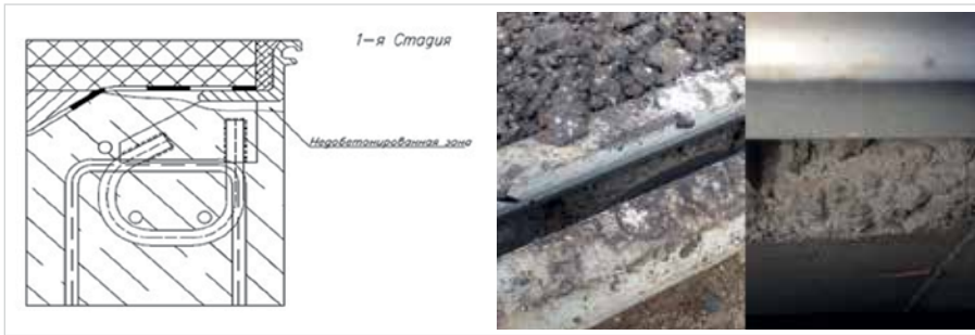
Рис. 6. Пазухи под полкой окаймления деформационного шва
