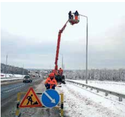
Монтаж опор освещения на «Восточном выезде» из Уфы
