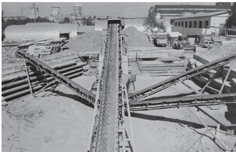
Рис. 3. Участок приема отходов на дробильно-сортировочном комплексе
