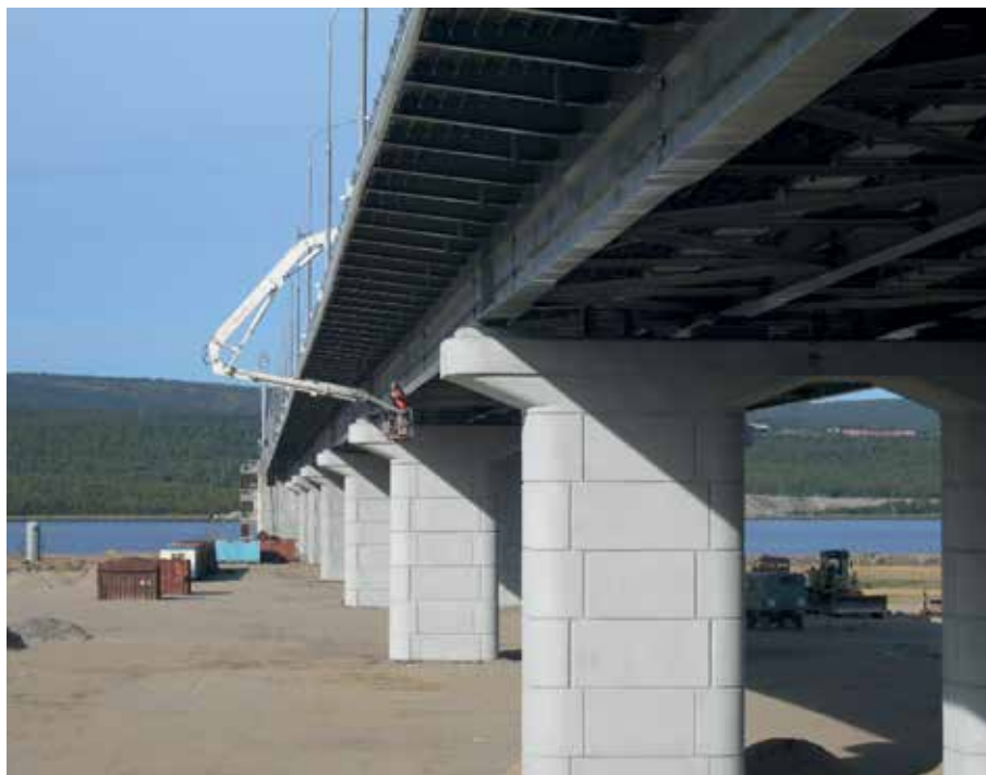
Рис. 4. Автогидроподъемник мостовой АГПМ-8/9-11 при обследовании внеклассного мостового сооружения
