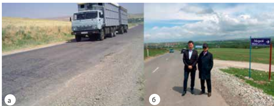
Рис. 1. а) 2018 год. Автомобильная дорога Александровка – Нестеровка с покрытием из шлакобетона со слоем износа из холодного асфальтобетона эксплуатировалась без ремонта 42 года (с декабря 1976 по 2018 год); б) 2019 год. Слой из асфальтобетона толщиной 5 см восстановлен
