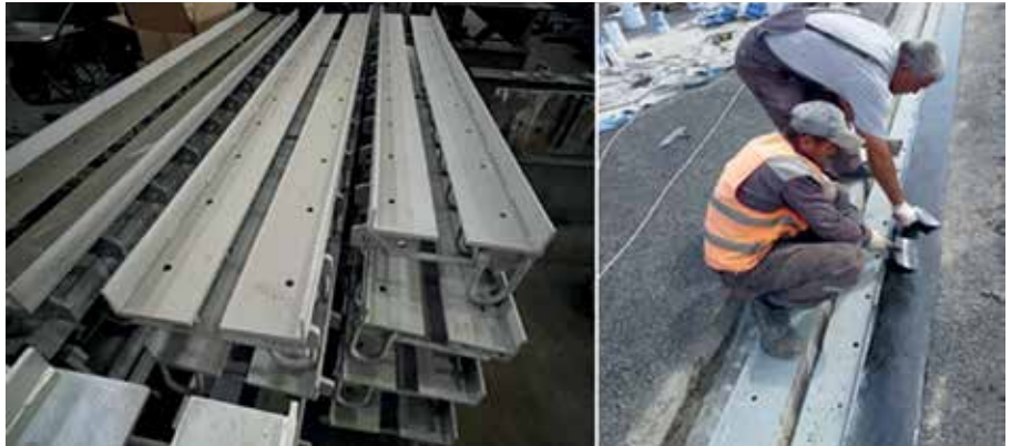
Рис. 12. Подконструкция для резинометаллических деформационных швов
