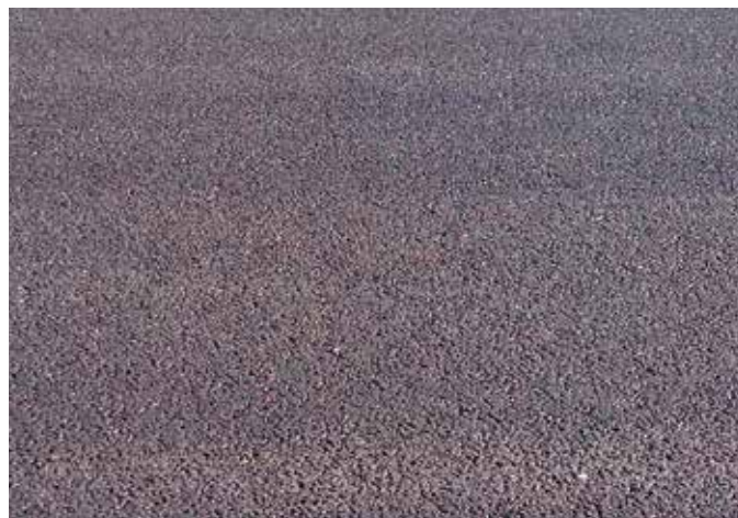
Рис. 4. Внешний вид покрытия из асфальтобетона АВГ
