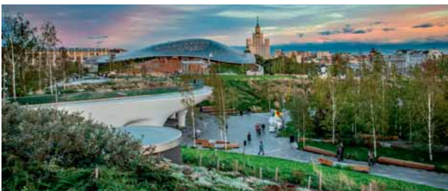
При строительстве парка «Зарядье» удалось снизить нагрузку на перекрытия подземных помещений от автомобильной техники и многолетних деревьев. Этот легкий, прочный и экологичный материал позволил утеплить заглубленные сооружения и придать рельефность ландшафту парка
