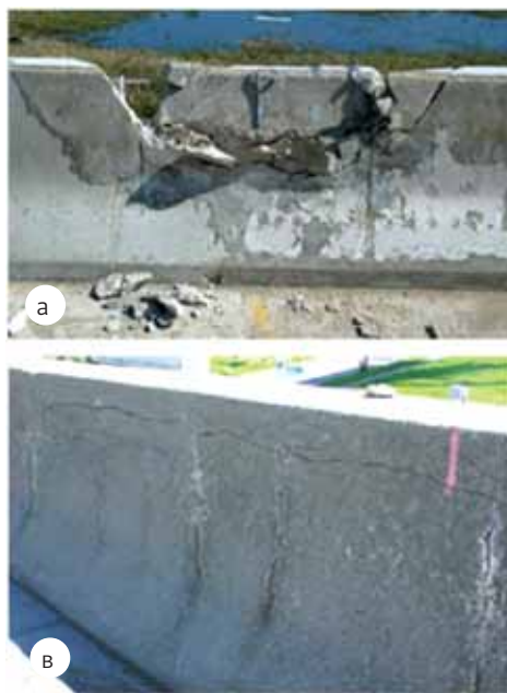
Рис. 26. Повреждения парапетных ограждений: а – тип Б; б – тип А; в – тип В; г – тип Г
