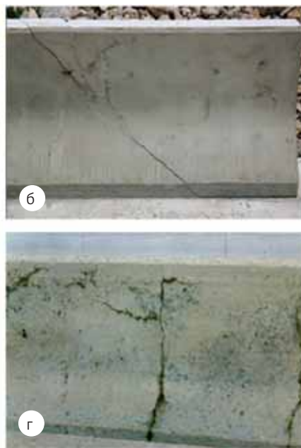
Рис. 26. Повреждения парапетных ограждений: а – тип Б; б – тип А; в – тип В; г – тип Г
