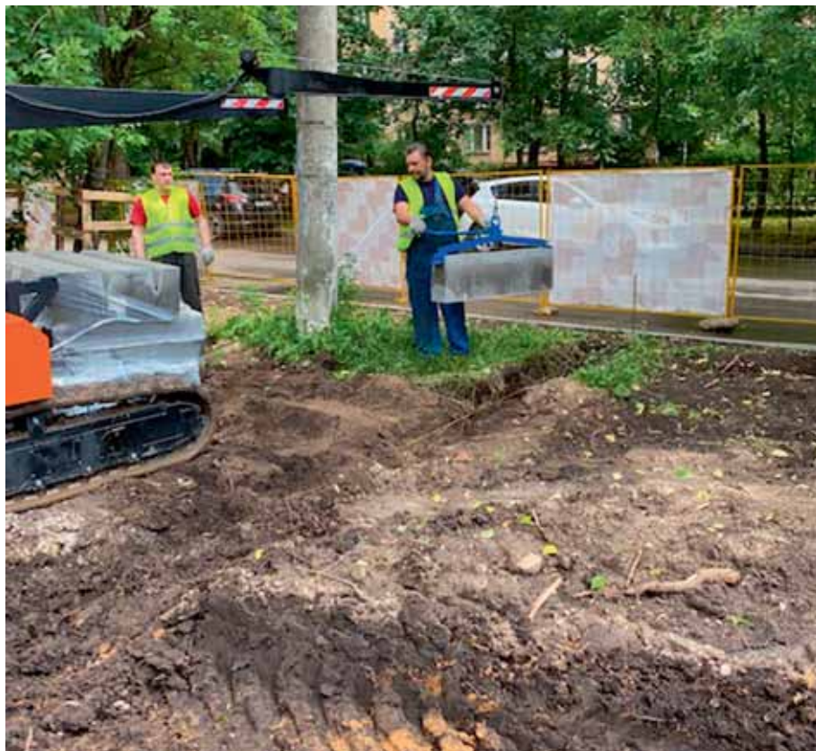
Фото 3. Оценка надежности захвата бордюра и его укладка
