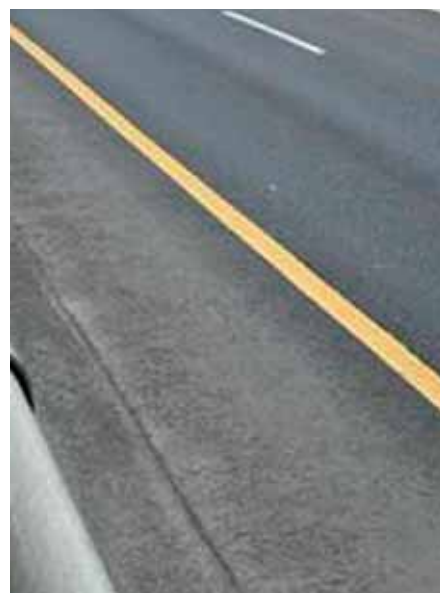
Рис. 1. Колея в пришовной зоне (покрытие из укатываемого асфальтобетона) на второй год эксплуатации
