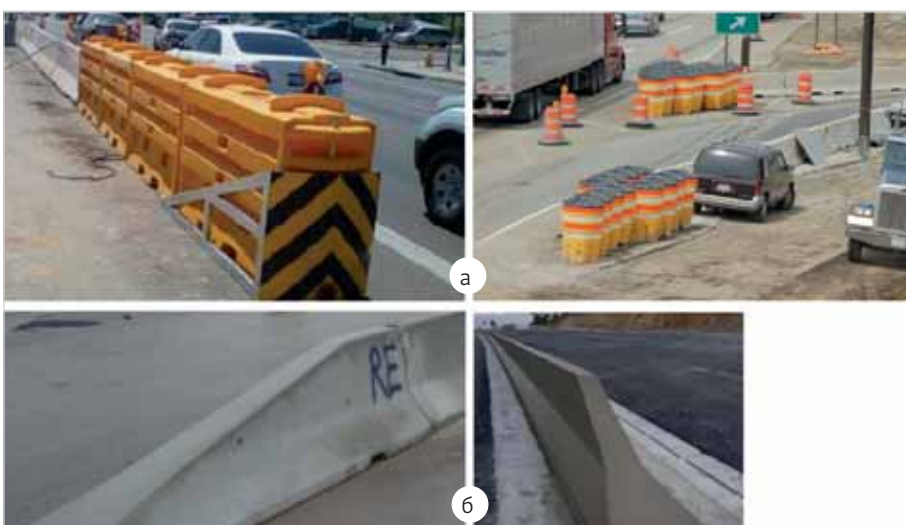
Рис. 11. Обустройство начала парашетного ограждения: а – фронтальное ограждение; б – блок начального участка
