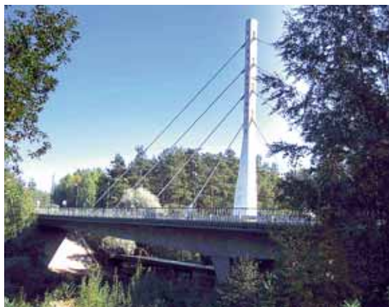
Рис. 7. Современный вид моста через реку Малая Сестра по дороге к санаторию «Белые ночи»
