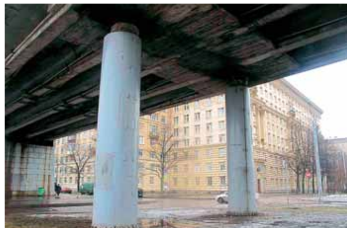
Рис. 6. Усиление опор путепровода
