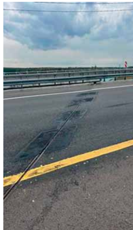
Рис. 4. Пришовная переходная зона по полосе наката
