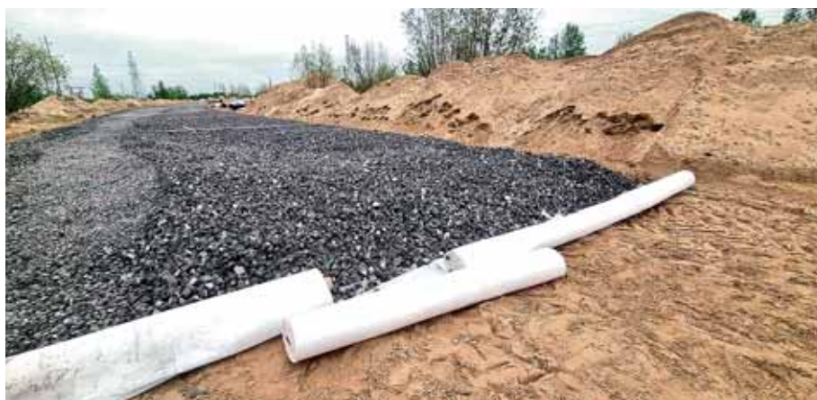
Укладка морозозащитного слоя из пеностекла фракционированного с целью снижения глубины промерзания и исключения процессов морозного пучения
