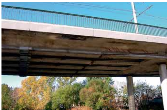
Рис. 5. Усиление балок пролетного строения
