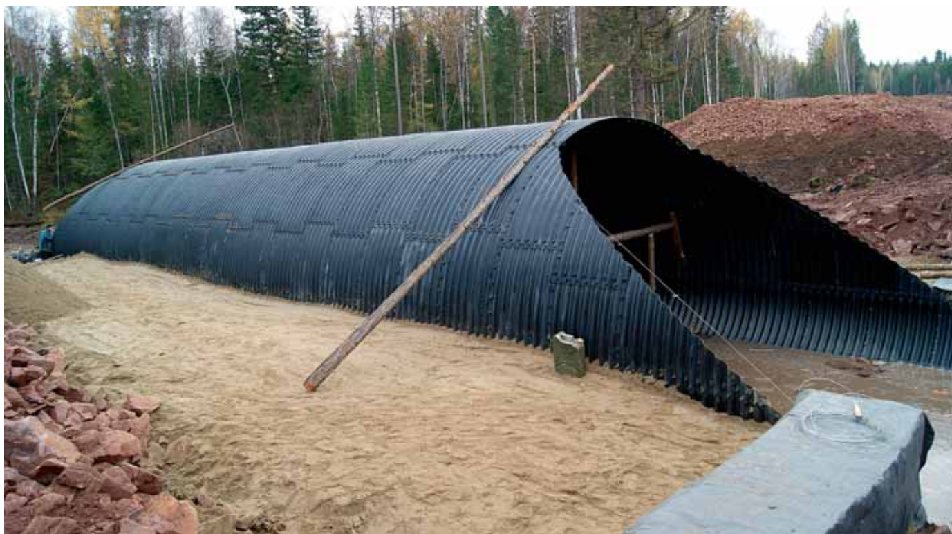
Трубная арка с комбинированным антикоррозионным и изоляционным покрытием
