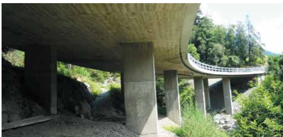
Рис. 6. Мост 2 после ремонтных работ
