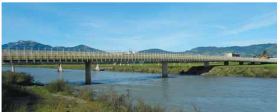
Рис. 4. Общий вид моста 1 с ремонтной обстройкой во время проведения работ в 2019 году
