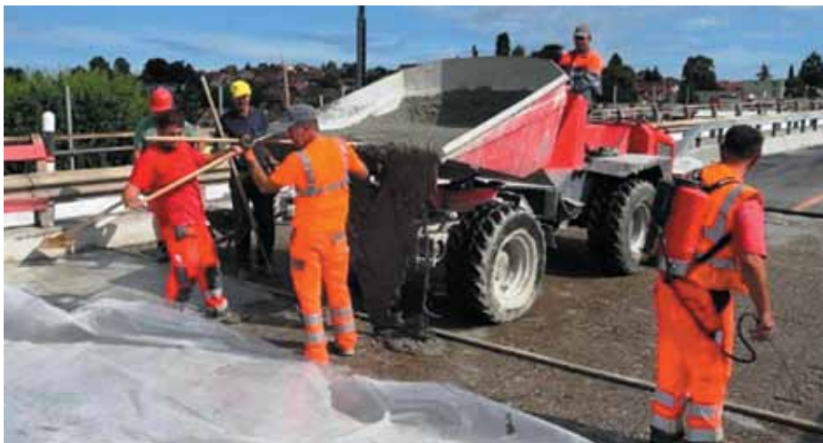
Рис. 9. Укладка UHPFRC вручную воскресным днем, летом 2016 года
