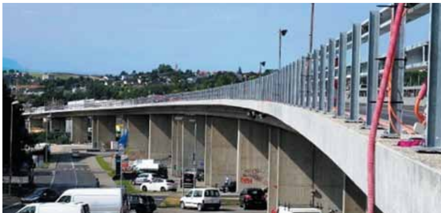
Рис. 8. Мост 3 длиной 450 м во время ремонтных работ с устройством добавленного слоя UHPFRC: карниз уже покрыт слоем UHPFRC
