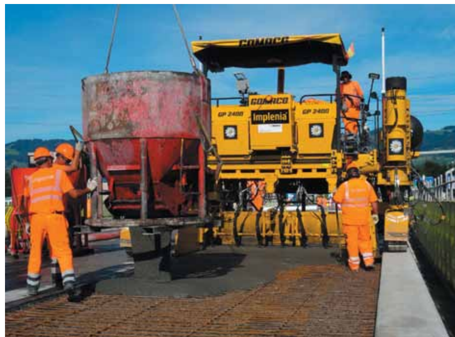
Рис. 5. Укладка бетона UHPFRC 10 сентября 2019 года
