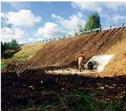
Рис. 2. Капитальный ремонт водопропускных труб в Касимовском районе Рязанской области Труба SPIREL диаметром 1 м, длина поз. м
