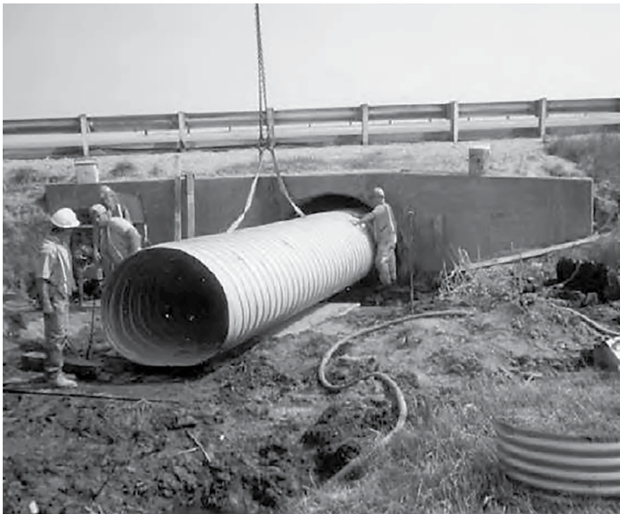
Рис. 1. Ремонт водопропускных труб методом гильзования
