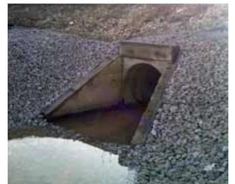
Рис. 3. Разрушенные железобетонные водопропускные трубы под автомобильной дорогой к аквапарку «Горки» в Рязанской области Труба SPIREL диаметром 1,2 м, длина 36,3 поз. м, Труба SPIREL диаметром 1 м, длина 43,2+33,2+30,1 поз. м
