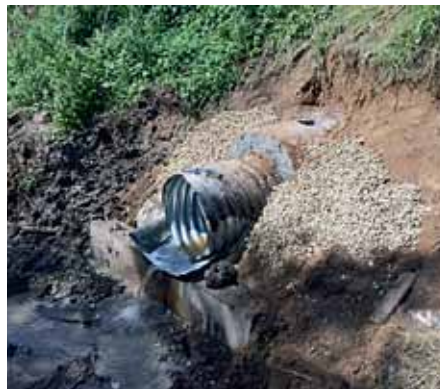
Рис. 2. Капитальный ремонт водопропускных труб в Касимовском районе Рязанской области Труба SPIREL диаметром 1 м, длина поз. м
