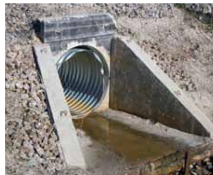
Рис. 3. Разрушенные железобетонные водопропускные трубы под автомобильной дорогой к аквапарку «Горки» в Рязанской области Труба SPIREL диаметром 1,2 м, длина 36,3 поз. м, Труба SPIREL диаметром 1 м, длина 43,2+33,2+30,1 поз. м
