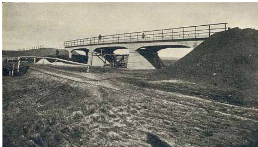
Рис. 2. Земский железобетонный мост на тракте Рыбушка – Синенькие Саратовского уезда
