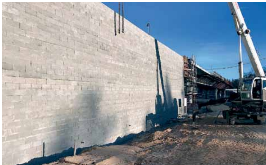
Система «Макволл®». ЦКАД-3, путепровод ПК 708. Генподрядчик – ДСК «Автобан»
