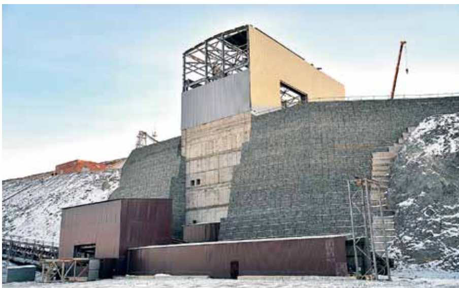
Армогрунтовая система «Террамеш®» в районе дробильной установки Михеевского ГОКа
