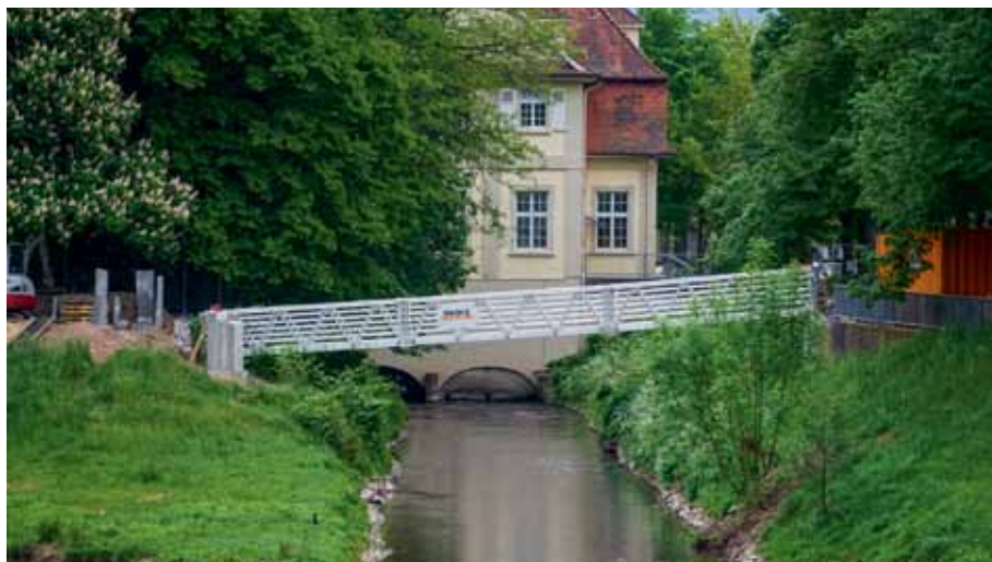
Изготовленный в Красноярске (КраМЗ) мост из анодированного алюминия длиной 18 м и шириной 2 м заменил временный «инвентарный» мост через реку Мург – приток Рейна
