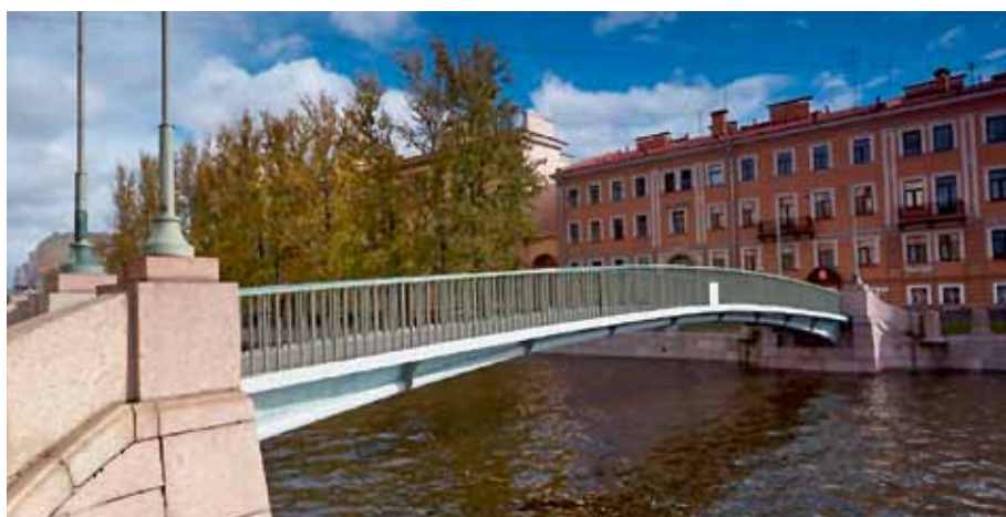
Коломенский мост построен в Санкт-Петербурге в 1969 году
