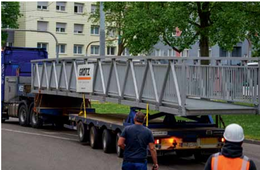
Монтаж алюминиевого моста не требует длительного перекрытия дорог
