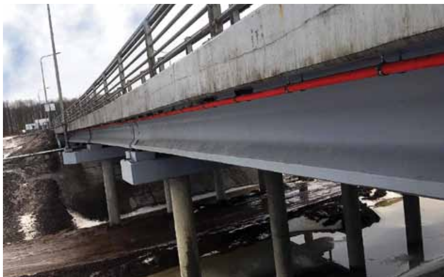
Фото 3. Общий вид ПК 2+52, боковая поверхность железобетонной плиты. (Видно хорошее состояние лакокрасочного покрытия на заводской части пролета)
