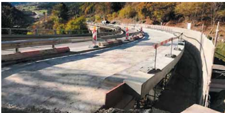
Рис. 7. Первая половина работ завершена в ноябре 2017 года. Слой UHPFRC на плите, карнизах и переходных плитах
