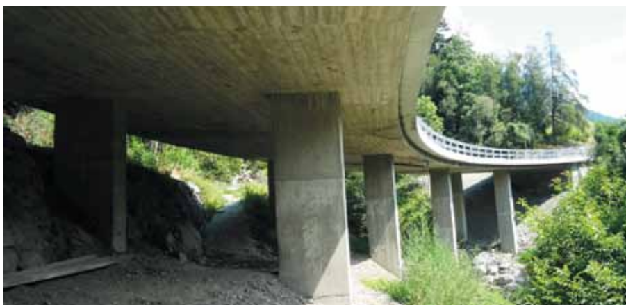
Рис. 6. Мост 2 после ремонтных работ
