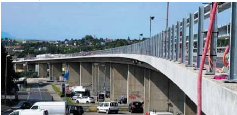
Рис. 8. Мост 3 длиной 450 м во время ремонтных работ с устройством добавленного слоя UHPFRC: карниз уже покрыт слоем UHPFRC
