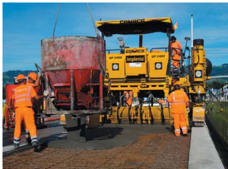
Рис. 5. Укладка бетона UHPFRC 10 сентября 2019 года
