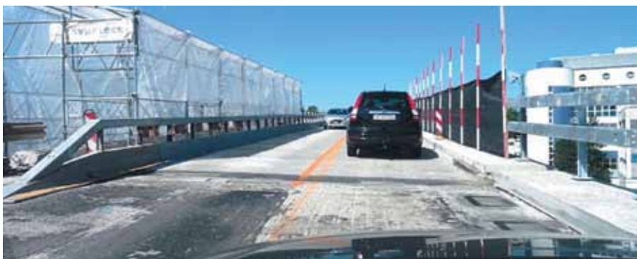
Рис. 10. Дорожная ситуация в выходные дни на «молодом» UHPFRC (слой светлого серого цвета) во время проведения работ по карнизам. Асфальтобетонное покрытие соседнего участка ремонта уже снято (темная поверхность)
