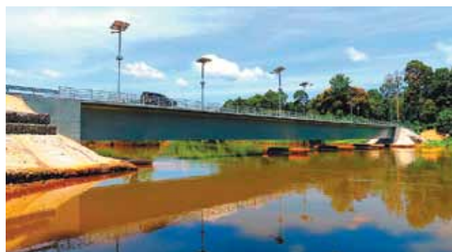
Рис. 10. Мост Batu 6 в Gerik Perak (Малайзия) с составным по длине пролетным строением из UHPFRC, пролет 100 м
