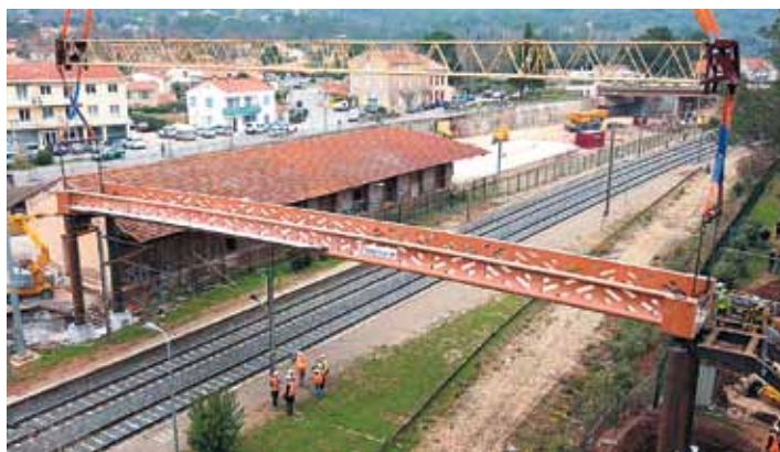
Рис. 7. Пешеходный переход через железнодорожные пути в Le Cannet-des-Maures (Франция), пролет 34 м
