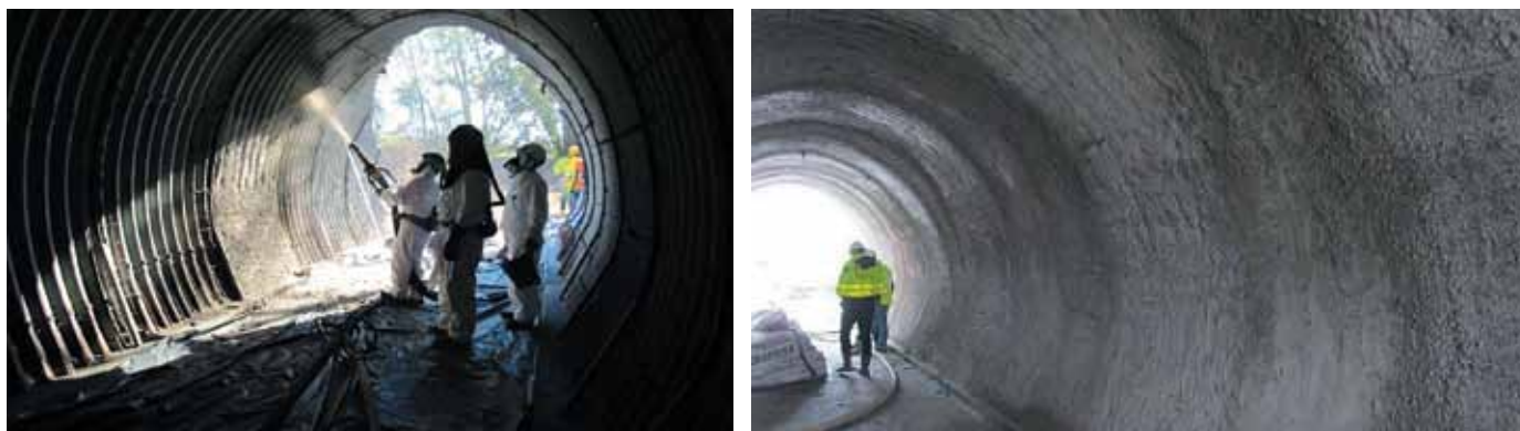
Рис. 14. Торкретирование Ductal® со стальной фиброй для ремонта и реконструкции водопропускных труб
