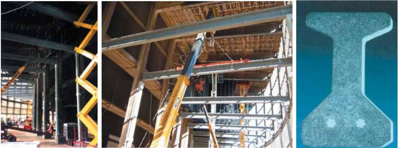
Рис. 5. Балки перекрытий корпусов охлаждения атомной электростанции Cattenom (Франция)
