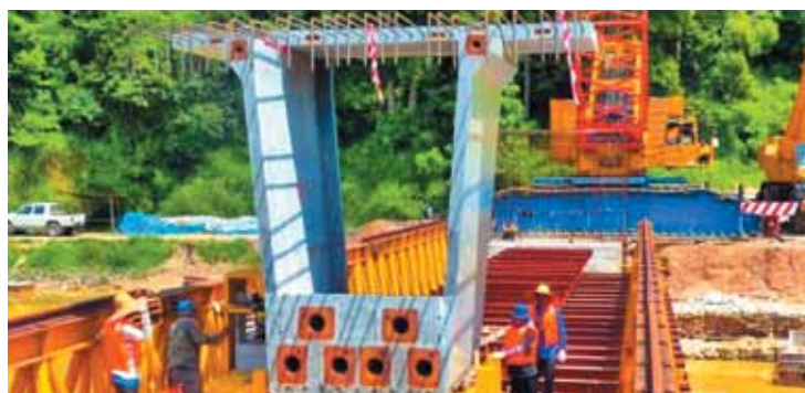
Рис. 10. Мост Batu 6 в Gerik Perak (Малайзия) с составным по длине пролетным строением из UHPFRC, пролет 100 м
