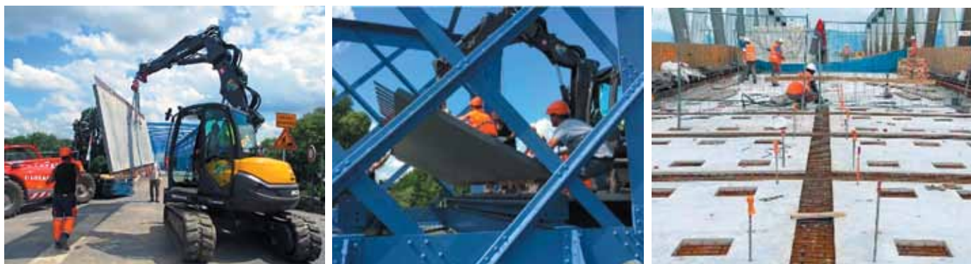
Рис. 13. Применение тонких сборных плит UHPFRC для ремонта проезжей части по стальной ортотропной плите
