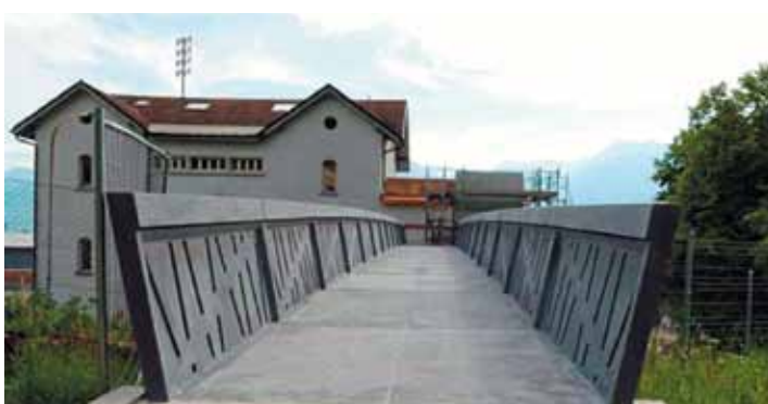
Рис. 8. Пешеходный переход через автодорогу в Le Bouveret (Швейцария), пролет 25 м
