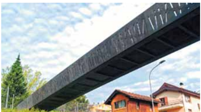
Рис. 8. Пешеходный переход через автодорогу в Le Bouveret (Швейцария), пролет 25 м
