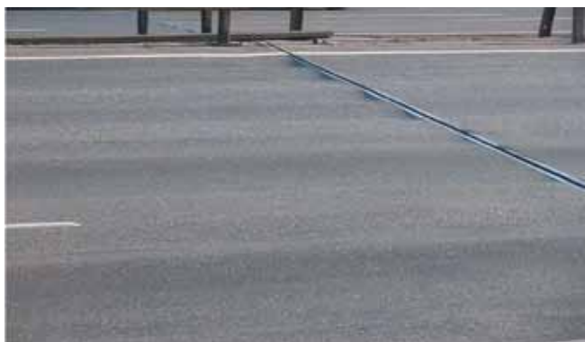
Характерные разрушения примыкания к деформационному шву
