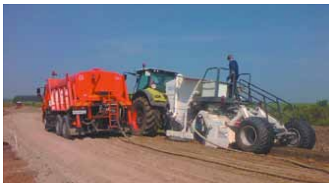
Фото 5. Распределение воды через навесной роторный смеситель (ресайклер)
