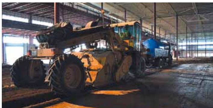
Фото 6. Распределение воды через самоходный ресайклер
