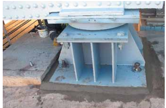
Рис. 8. Шаровая сегментная опорная часть с переходной тумбой на мосту через реку Нарову
