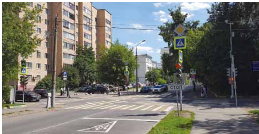
Рис. 2. Горизонтальная дорожная разметка перекрестка, включая «диагональную» разметку 1.14.1 с желтым заполнением, что не соответствует проекту новой редакции ГОСТ Р 52289
