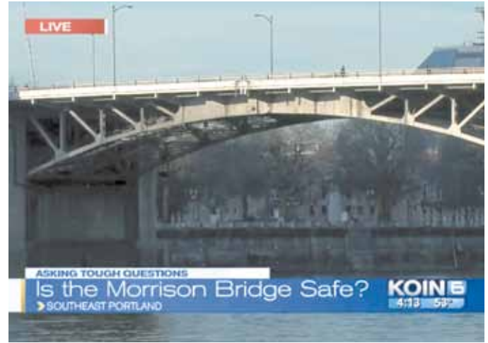
Рис. 10. Разводной мост Моррисон после реконструкции в наведенном положении. Портленд, штат Орегон, США (Выдержка из Live news, USA)
