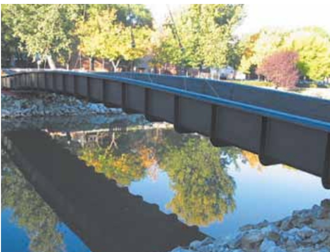
Рис. 3. Мост, изготовленный из углепластика, в Мадриде
