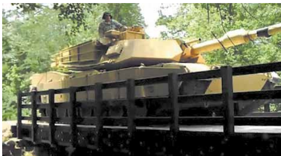
Рис. 5. Пластиковый мост, способный выдержать М1 «Абрамс»
