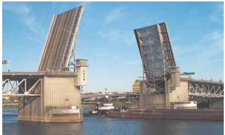
Рис. 11. Разводной мост Моррисон после реконструкции в разведенном положении. Портленд, штат Орегон, США
