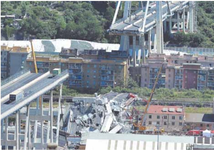
Рис. 7. Вид рухнувшей 14.08.2018 части виадукта в Генуе ( static.standard.co.uk/s3fs-public/thumbnails/image/2018/08/15/16/enoabridgecollapse1508a.jpg )
