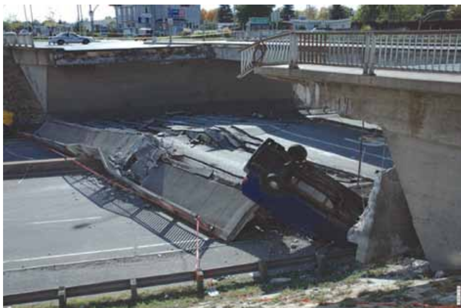
Рис. 9. Обрушение путепровода Конкорд в Канаде 30.09.2006 ( cip.management.dal.ca/publications/report_eng%20concorde%20overpass%20montreal.pdf )
