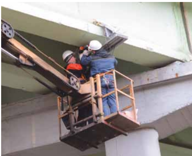
Рис. 10. Неразрушающий контроль преднапряженных балок пролетных строений МС при помощи магнитного дефектоскопа «Интрос»
