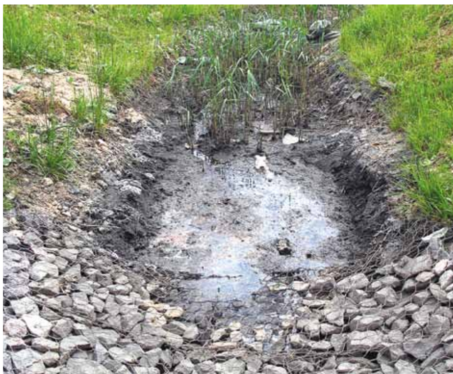
Рис. 3. Заиливание водотока, выполненного из матрацев Рено
