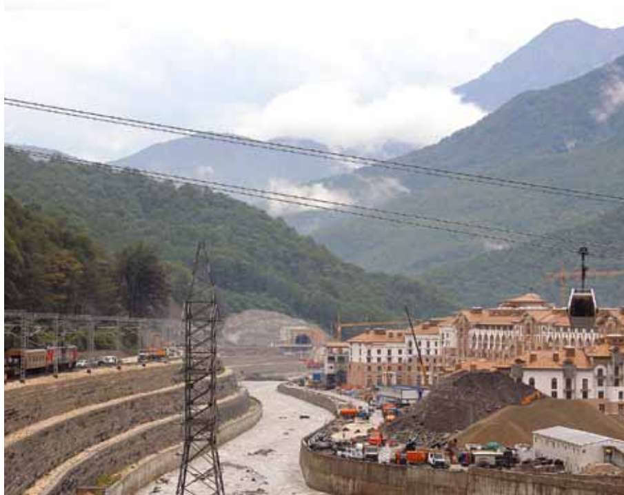
Рис. 2. Строительство совмещенной дороги Адлер – горноклиматический курорт «Альпика-Сервис»
