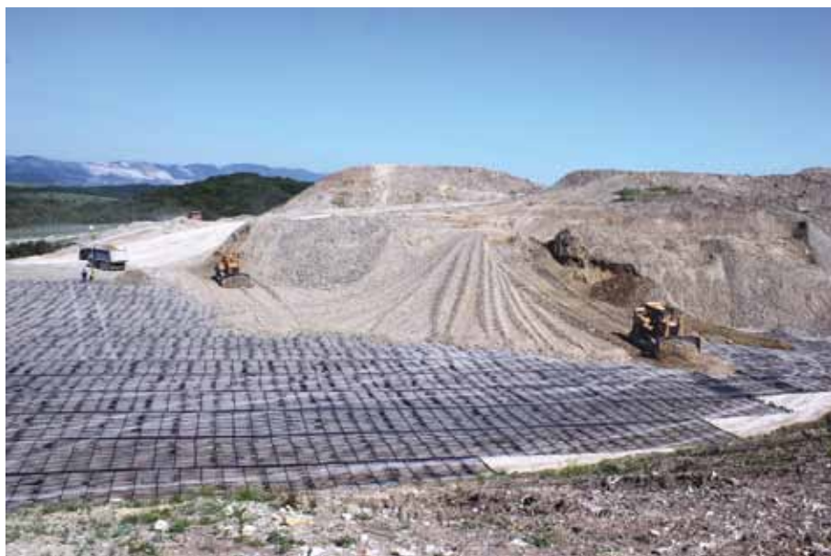
Рис. 5. Строительство резервуарного парка Каспийского трубопроводного консорциума
