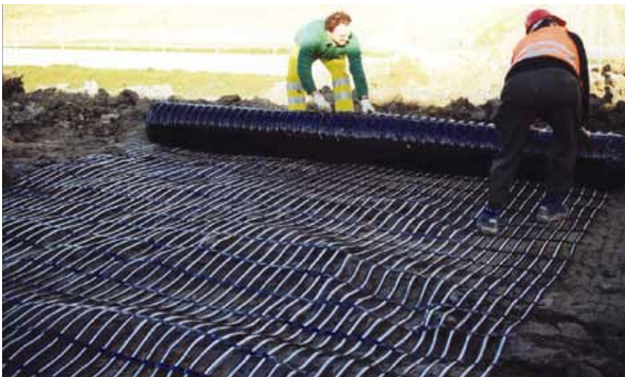
Рис. 9. Армирование дамбы и искусственного пруда для горнолыжного комплекса «Альпика-Сервис»
