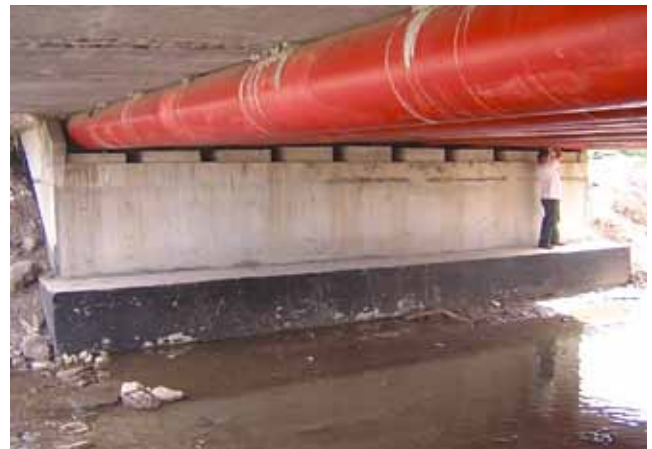
Рис. 14. Малый мост из старогодных труб на автодороге Казань – Киров
