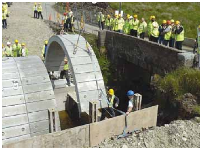
Рис. 9. Монтаж арочного пролетного строения FlexiArch
