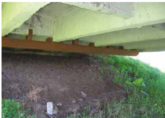
Рис. 1. Объединение балок пролетного строения и диафрагм
