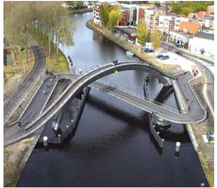
Рис. 22. Двухэтажный пешеходно-велосипедный мост с разделным движением в Нидерландах
