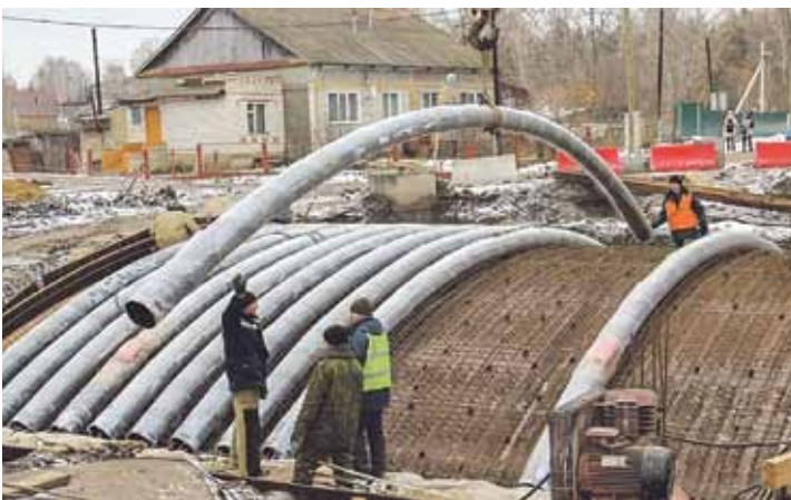
Рис. 13. Процесс строительства этого моста с трубобетонными несущими арками
