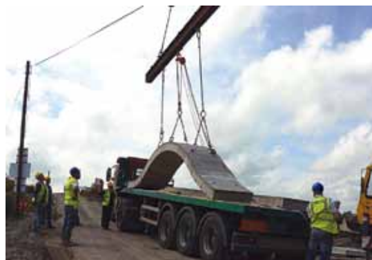
Рис. 8. Изгиб пролетного строения в арочную форму при подъеме
