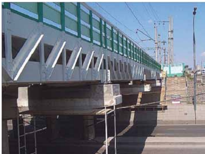
Рис. 5. Мост с пролетным строением из полимерного композитного материала
