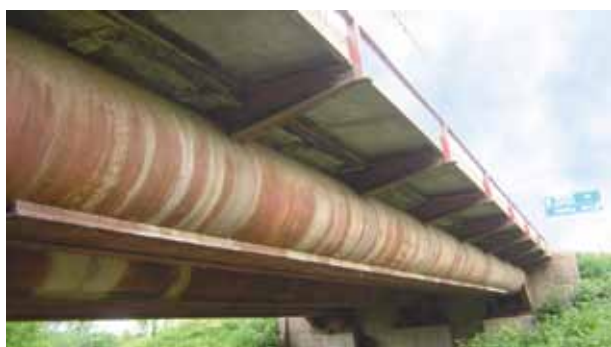
Рис. 15. Малый мост с трубчатым пролетным строением, усиленным уголками
