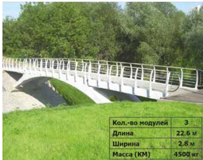
Рис. 6. Арочный мост из полимерного композитного материала
