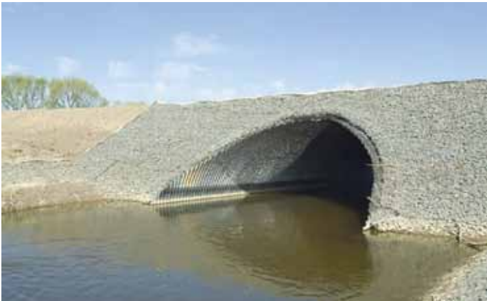
Рис. 11. Грунтозасыпной арочный мост с несущим металлическим гофрированным сводом
