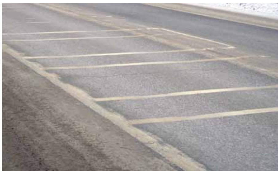
Рис. 5. Внешний вид участка СПИ 2017–2018 на автомобильной дороге К-12 Новосибирск – Томск, км 30 (с асфальтобетонным покрытием)
