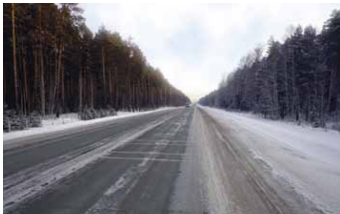
Рис. 3. Внешний вид участка СПИ 2017–2018 на автомобильной дороге Р-255 на участке Северного обхода г. Новосибирска, км 21 (с асфальтобетонным покрытием)
