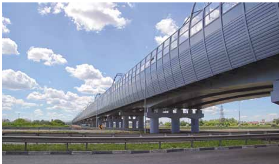
Железнодорожная эстакада к новому вокзалу, г. Астана
