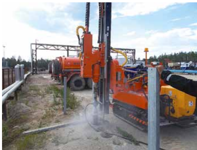
Рис. 11. Установка МСУ-800 (1200) укомплектованная пневмоударником и компрессорной установкой
