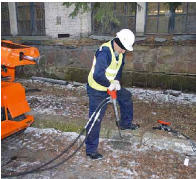
Рис. 8. Работа с отбойным молотком
