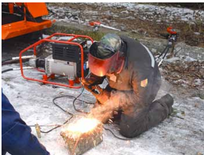
Рис. 10. Работа сварочным универсальным аппаратом
