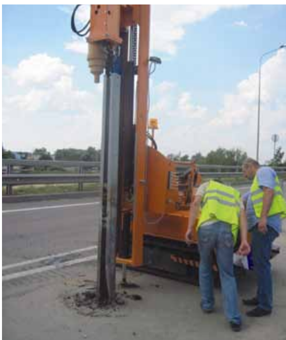
Рис. 6. Установка МСУ-800 (1200) с экстрактором для извлечения старых стоек
