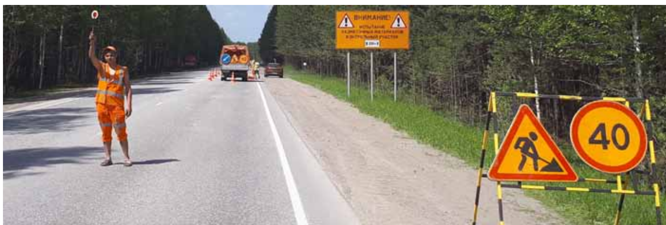
Рис. 6. Контрольные линии через двенадцать месяцев эксплуатации (десять месяцев – для полимерных лент). Автомобильная дорога К-12 Новосибирск – Томск, км 30 (с асфальтобетонным покрытием), находящаяся под управлением ГКУ НСО ТУАД
