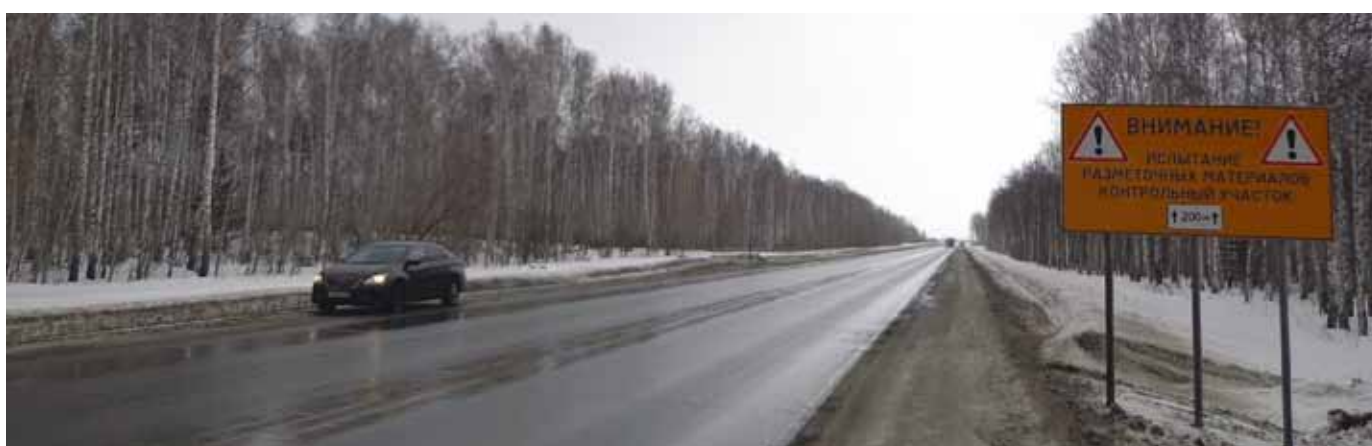
Рис. 2. Контрольные линии через девять месяцев эксплуатации (семь месяцев – для полимерных лент). Автомобильная дорога Р-255 «Сибирь» на участке Северного обхода г. Новосибирска, км 29 (с цементобетонным покрытием)
