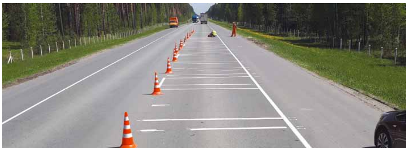
Рис. 4. Контрольные линии через двенадцать месяцев эксплуатации (десять месяцев – для полимерных лент). Автомобильная дорога Р-255 «Сибирь» на участке Северного обхода г. Новосибирска, км 21 (с асфальтобетонным покрытием)
