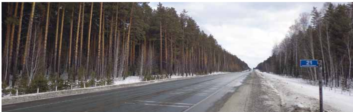
Рис. 1. Контрольные линии через девять месяцев эксплуатации (семь месяцев – для полимерных лент). Автомобильная дорога Р-255 «Сибирь» на участке Северного обхода г. Новосибирска, км 21 (с асфальтобетонным покрытием)
