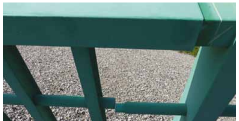
Рис. 19. Небрежный монтаж перильного ограждения, приведший к повреждению поручня, нарушению стыковки элементов
