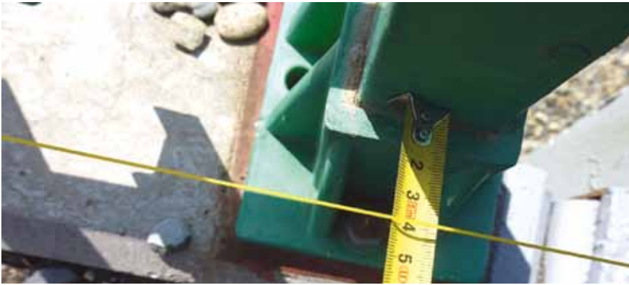
Рис. 16. Отклонение оси перильного ограждения от проектного положения в плане
