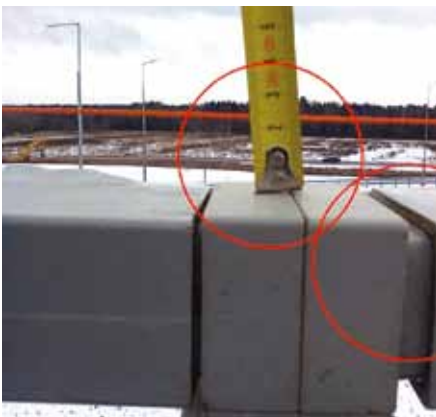
Рис. 17. Отклонение от проектного положения в профиле (опускание на 2,5 см)
