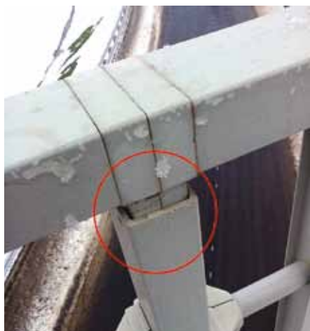
Рис. 20. Неплотное соединение элементов и соединение с натягом, приведшее к появлению трещины в поручне
