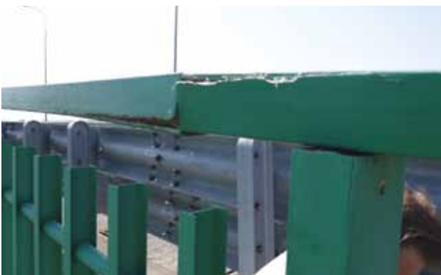
Рис. 19. Небрежный монтаж перильного ограждения, приведший к повреждению поручня, нарушению стыковки элементов
