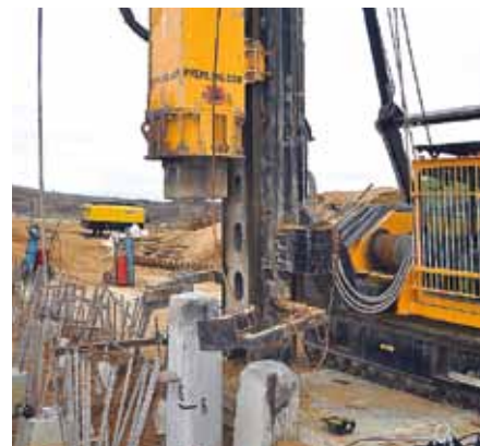
Рис. 2. Проведение динамических испытаний ж/б призматической сваи
