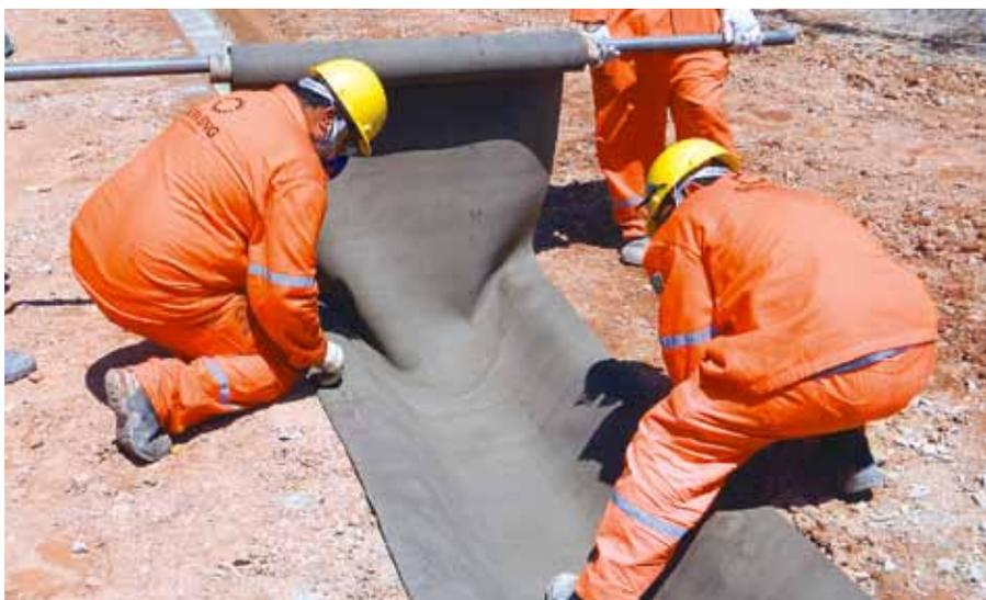
конструкций. Материал укладывается сверху и скрепляется с существующим бетонным основанием, предотвращая его дальнейшее разрушение, обеспечивая высокую прочность и защиту от эрозии.
