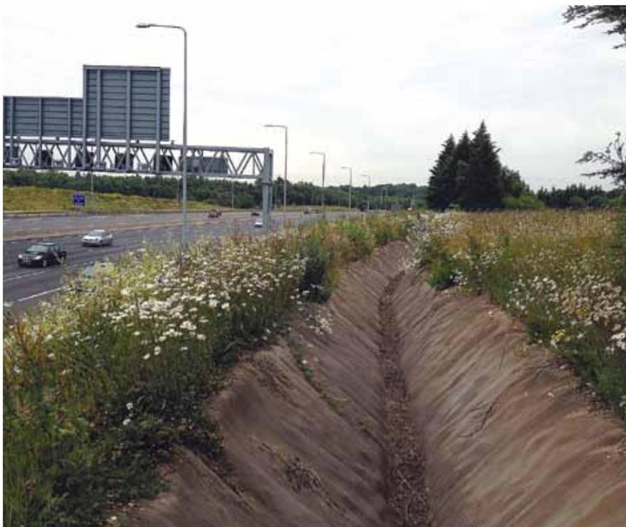
(ширина, глубина и прочие параметры значения не имеют). Благодаря своей прочности полотно одинаково эффективно укрепляет канавы и траншеи, проложенные в песчаном, глинистом и других видах грунта. Материал можно укладывать при любых погодных условиях, даже в проливной дождь. Более того, в случае, когда нет возможности остановить поток воды, монтаж можно проводить прямо в воде.
