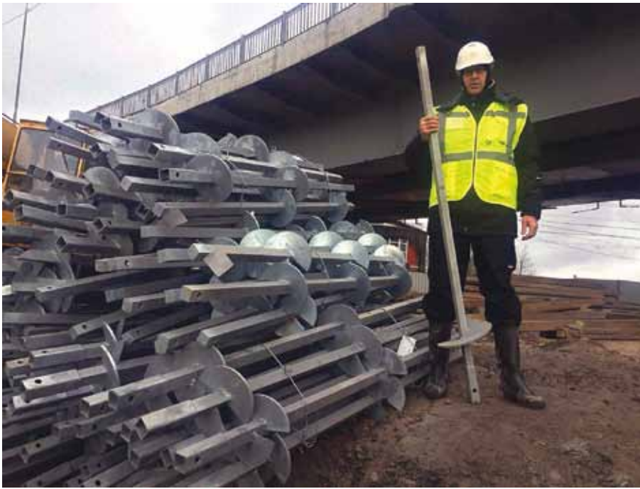
Рис. 2. Правильная винтовая свая с толстыми лопастями
