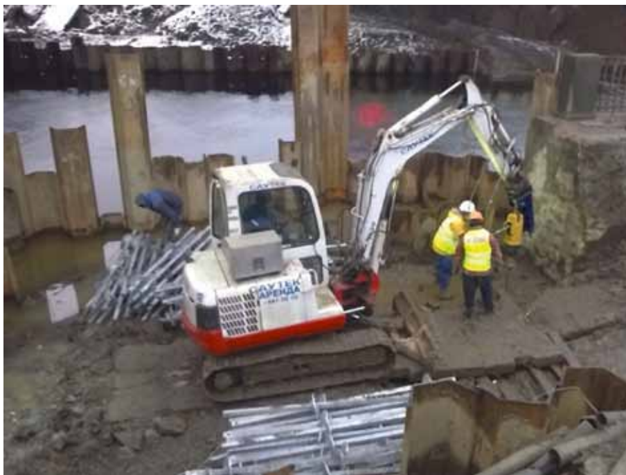
Рис. 4. Работы по погружению на набережной Обводного канала
