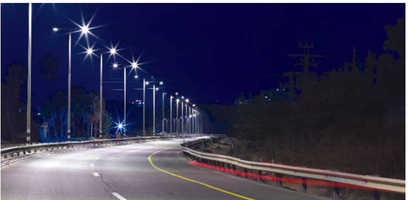
Рис. 4. Пример появления цветных полос на дорожном покрытии [mikhail.krivyy.com]
