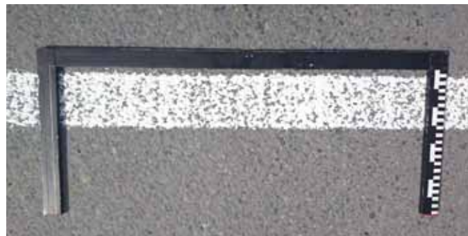
Рис. 11. Контрольная линия структурной горизонтальной дорожной разметки, выполненная холодным пластиком
