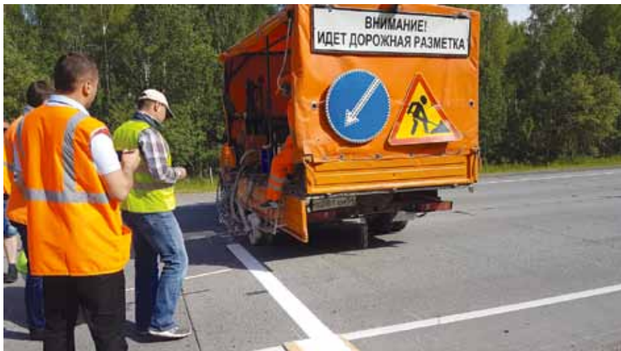
Рис. 1. Нанесение контрольной линии горизонтальной дорожной разметки краской (эмалью) на участке автомобильной дороги Р-254 «Сибирь» с цементобетонным покрытием
