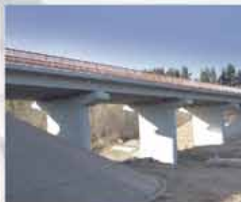
Ремонт моста через р. Паденьга на 834+990км автомобильной дороги М-8
