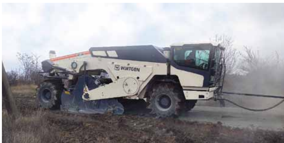
Измельчение асфальтобетонного покрытия и внесение в полученный гранулят КГЦ
