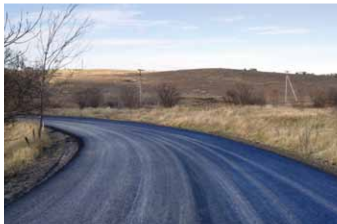
Асфальтобетонное покрытие, устроенное поверх стабилизированного основания
