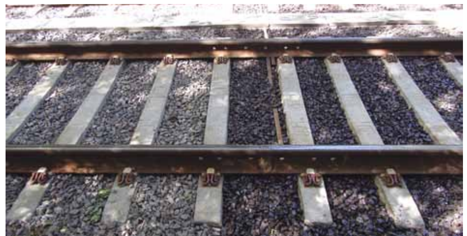
Участок трамвайных путей с укреплением щебеночного балласта материалом ДОРОЛИТ® (справа) и без укрепления (слева)
