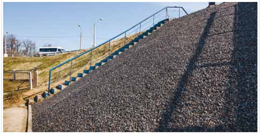
Состояние объекта «МКАД, 34 км, Бутовская развязка» до и после выполнения работ
