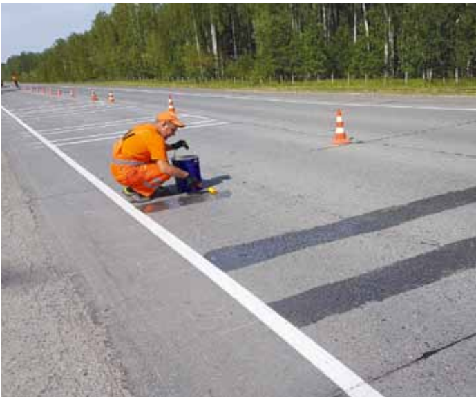
Рис. 4. Подгрунтовка поверхности перед устройством контрольных линий из термопластика
