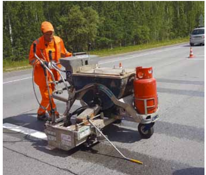
Рис. 5. Нанесение контрольной линии термопластиком на предварительно подгрунтованную поверхность на участке с цементобетонным покрытием специалистом ООО «Технодор»
