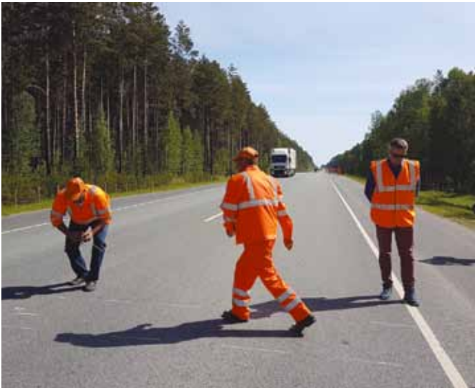
Рис. 2. Нанесение предварительной разметки на одном из экспериментальных участков СПИ 2017–2018
