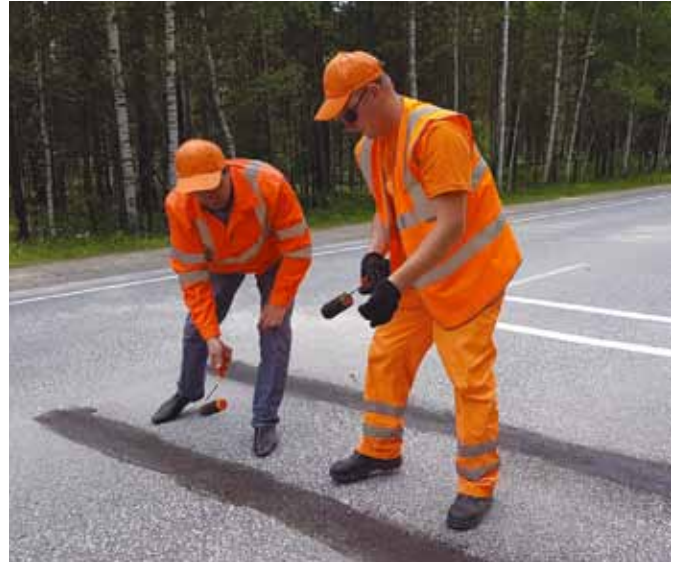
Рис. 3. Подгрунтовка поверхности перед устройством контрольных линий из штучных форм
