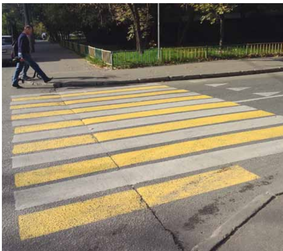
Рис. 4. Горизонтальная дорожная разметка 1.14.1 с окрашенным покрытием проезжей части между линиями разметки краской для дорожной разметки желтого цвета
