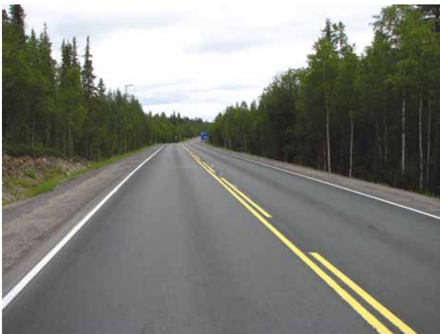
Рис. 5. Горизонтальная дорожная разметка, разделяющая потоки встречных направлений, нанесена материалом желтого цвета
