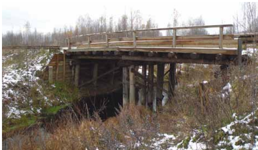
Рис.3. Мост через реку Оборля на автодороге Селеево – Иструбище в Холмском районе Новгородской области
