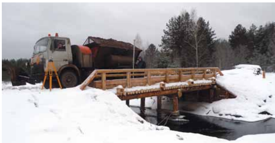
Рис. 5. Испытание моста через реку Волжанку
