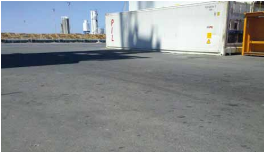
Рис. 5. Состояние покрытия HiMA через 2,5 года эксплуатации
