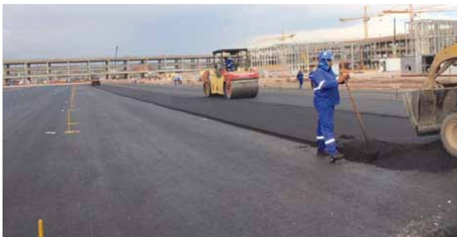
Рис. 10. Укладка верхнего слоя НiМА покрытия нового терминала аэропорта
