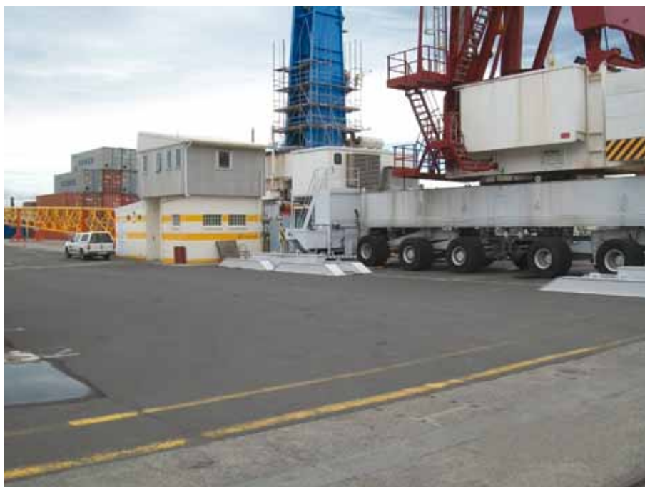
Рис. 4. Состояние покрытия HiMA зоны ПРР через 3 месяца эксплуатации.
