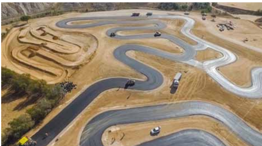
Рис. 6. Строительство гоночного трека DR7, Таранкон, провинция Куэнка, Испания
