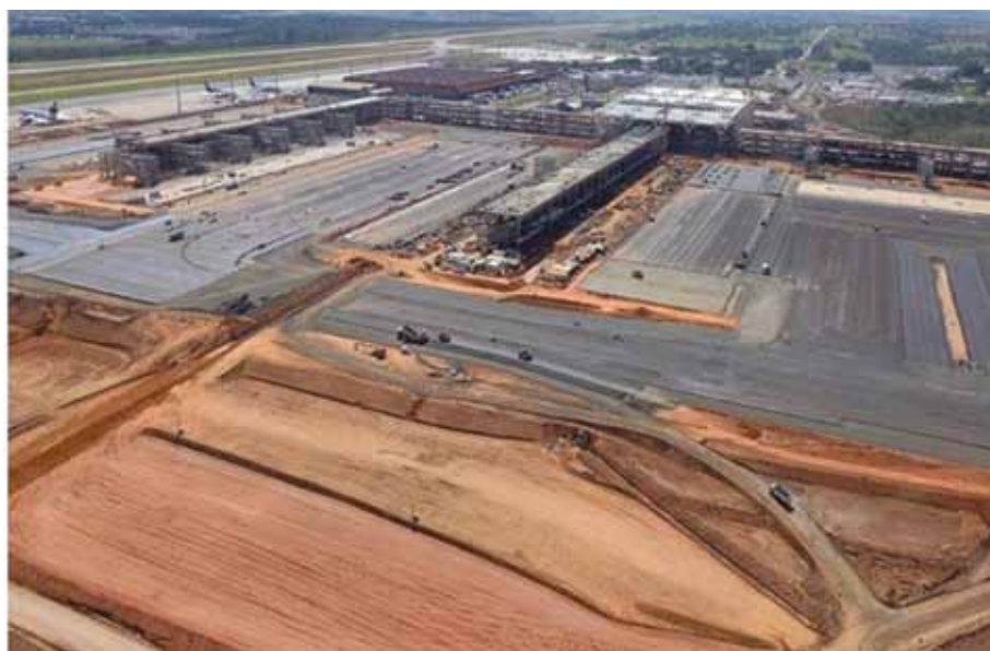
Рис. 11. Общий вид строящегося нового терминала
