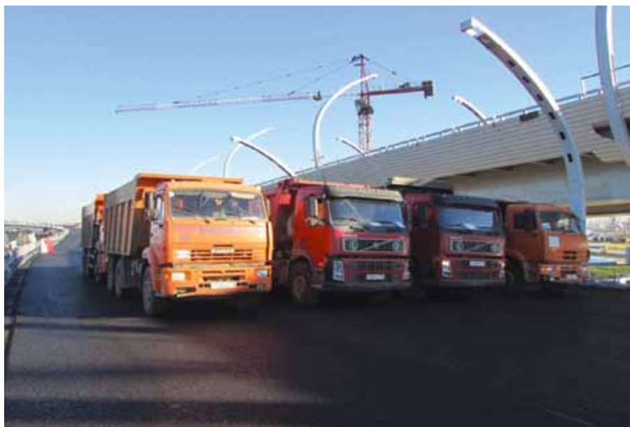
Рис. 3. Испытательная нагрузка на левом раздельном пролетном строении
