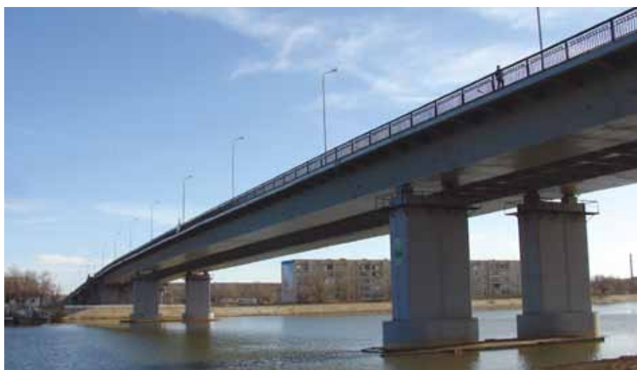
Автомобильный мост через р. Урал, г. Атырау
