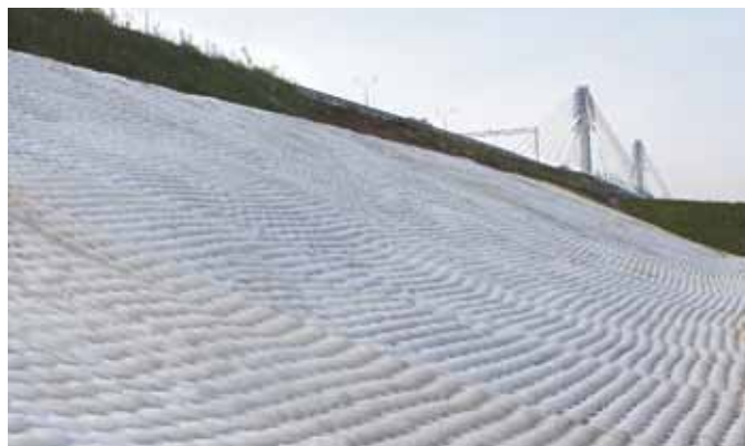
Фото 4. Укрепление откосов мостового перехода «Кировский» через р. Самара
