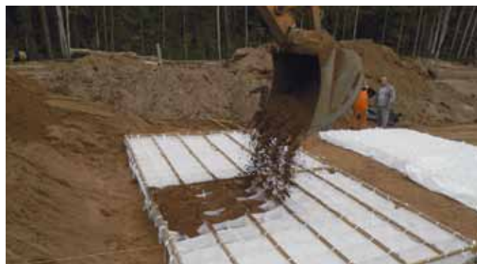
Фото 2. Засыпка геооболочек грунтом
