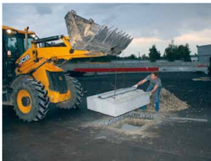
Фото 3. Монтаж модели шва в проектное положение
