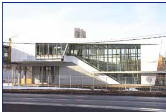
Москва, пешеходные мосты на ТПУ МЦК Московской ж. д.
