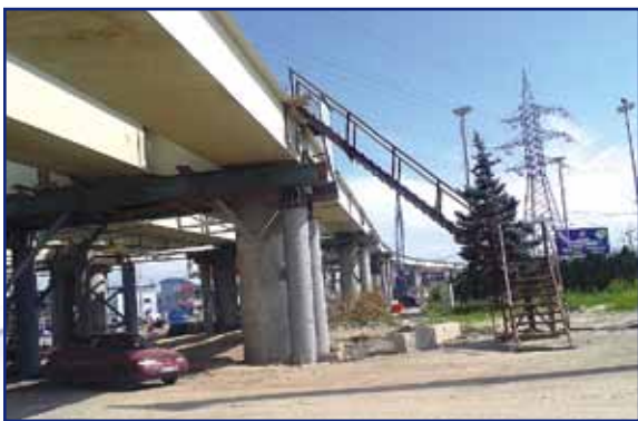
Ростов-на-Дону, левобережная эстакада моста через реку Дон
