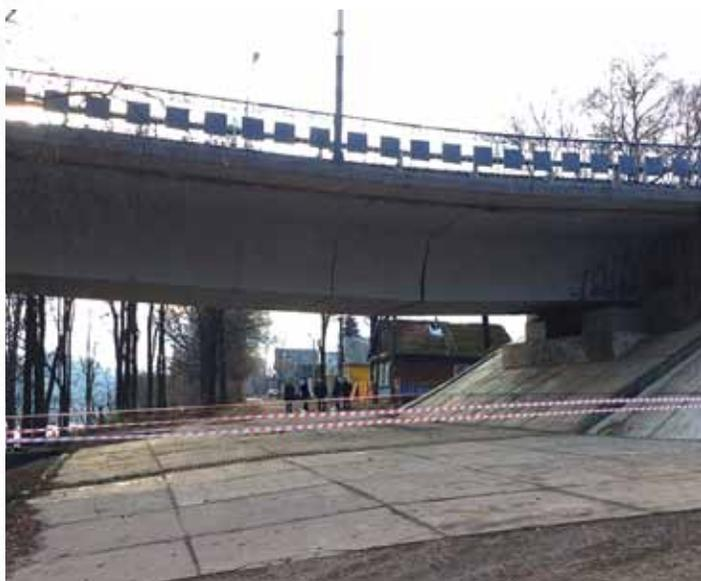
*В пролете 5–6 произошло разрушение стыков Б3-Б4 и Б4-Б5 с образованием глубокого провисания блока Б4*
