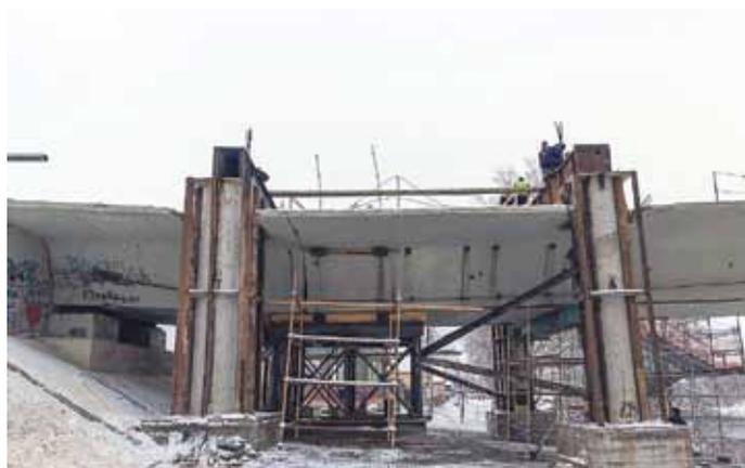
*Установка специальных временных устройств для подъёмки*
