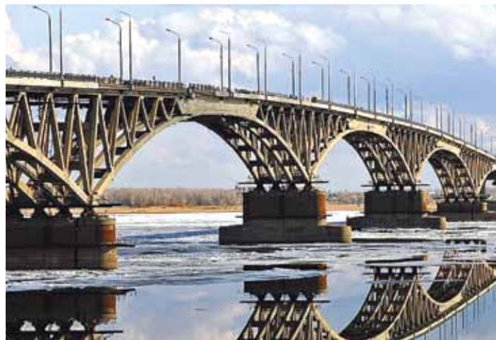
Рис. 6. Автодорожный мост через реку Волгу в Саратове (1965 г. п.)
