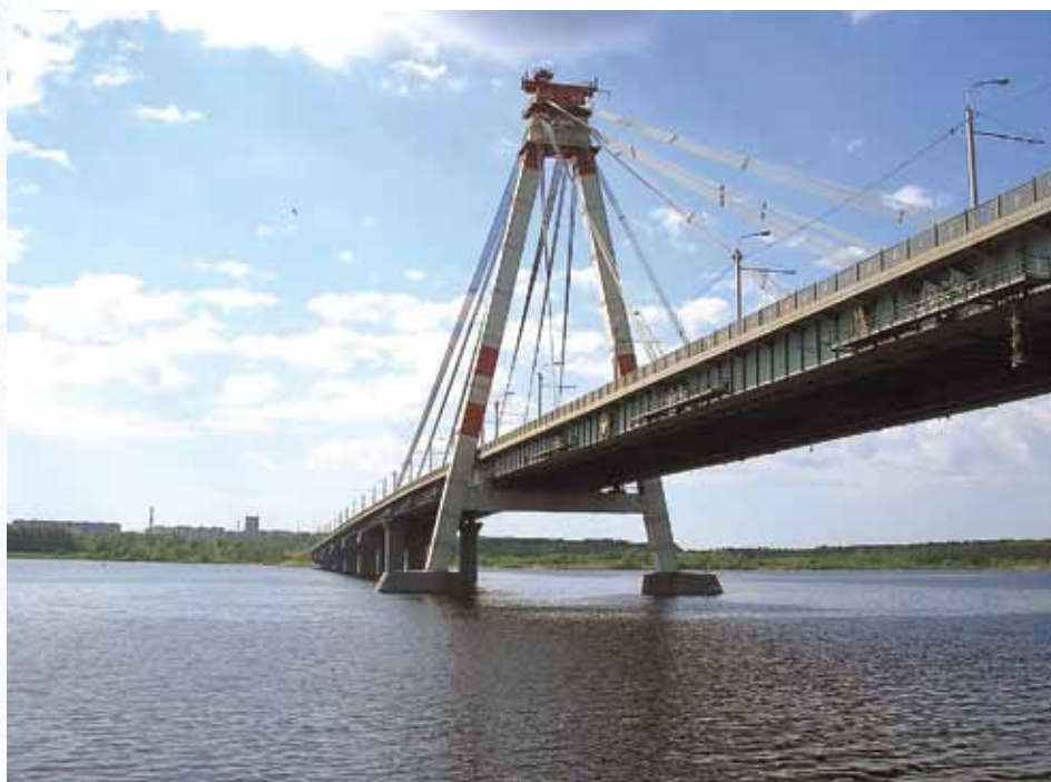
Вантовый мост через реку Шексна, г. Череповец
