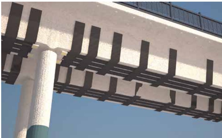
Усиление пролетного строения мостового сооружения
