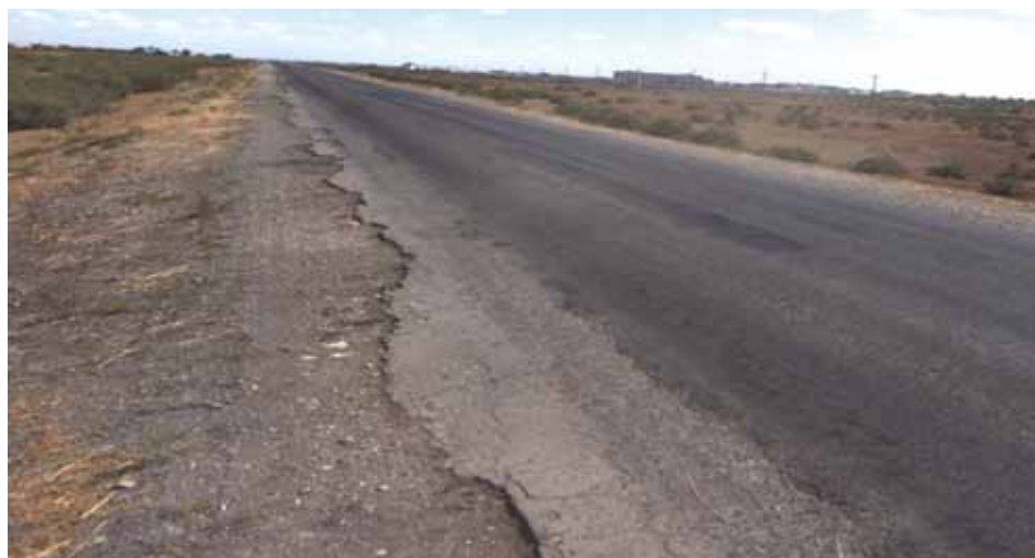
Рис. 1. Пример дороги, по которой выполнялось лазерное сканирование
