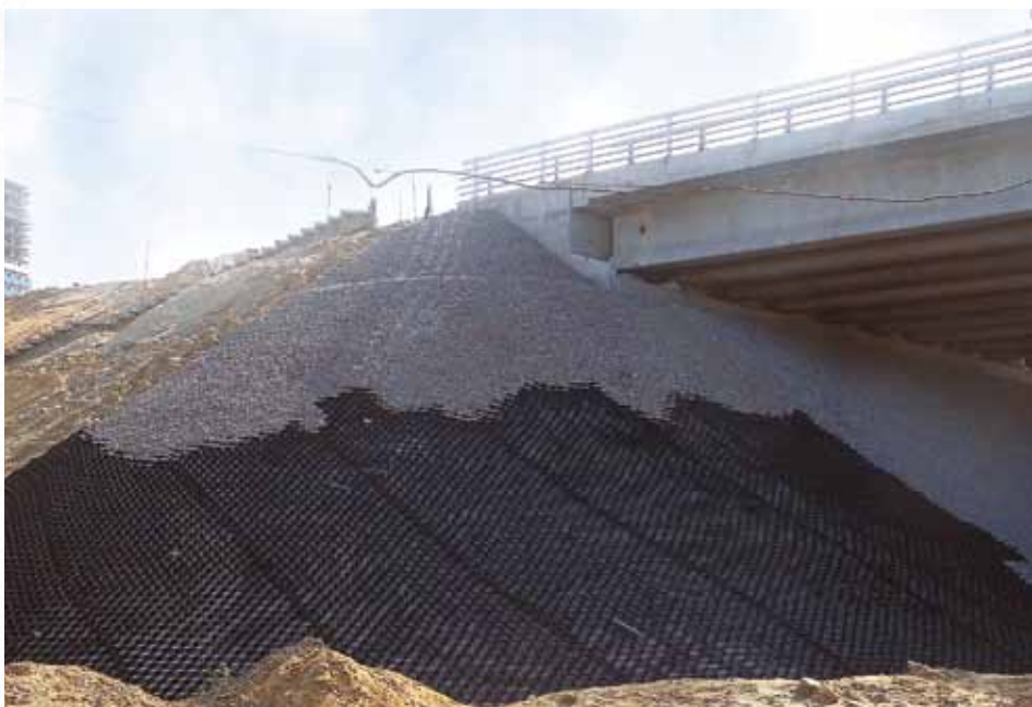
Обход поселка Холмогоры, трасса М8. Георешетка ППР GW производства ООО «Престо-Русь»
