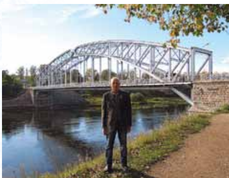
Рис. 3. Мост проф. Белелюбского в г. Боровичи
