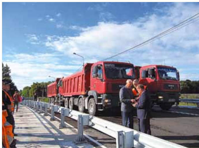
Рис. 1. Испытание путепровода по аллее Смелых в Калининграде после ремонта
