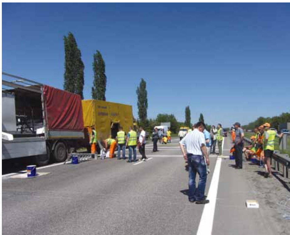
Рис. 1. Нанесение контрольных линий
