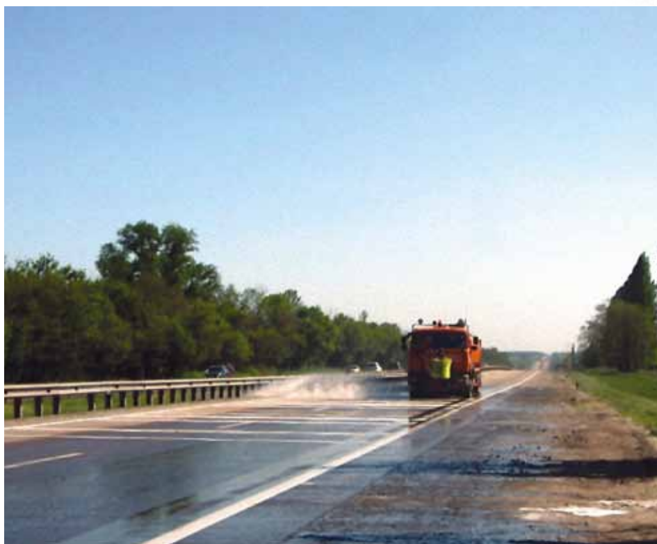
Рис. 10. Промывка участка СПИ после нанесения контрольных линий до открытия движения транспортных средств
