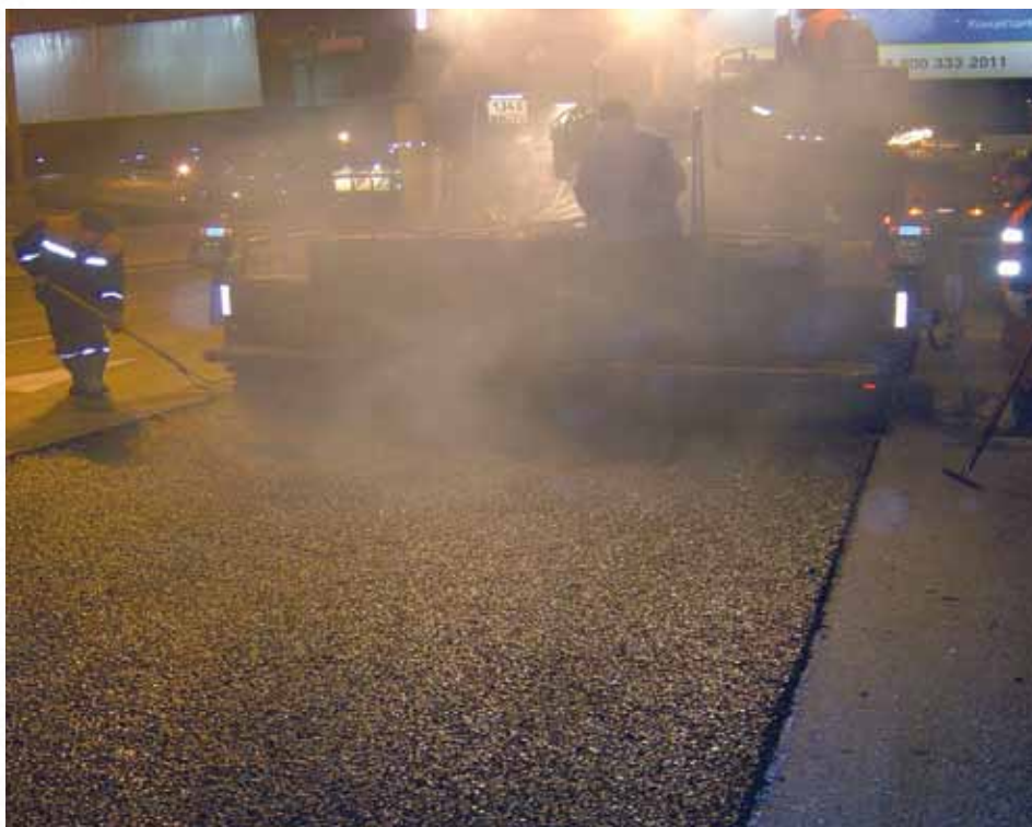
Фото 6. Устройство верхнего слоя из вибролитой смеси ВЛА-15 толщиной 30 мм (Москва, 86–87 км МКАД, декабрь 2010. Температура воздуха: –12°С)
