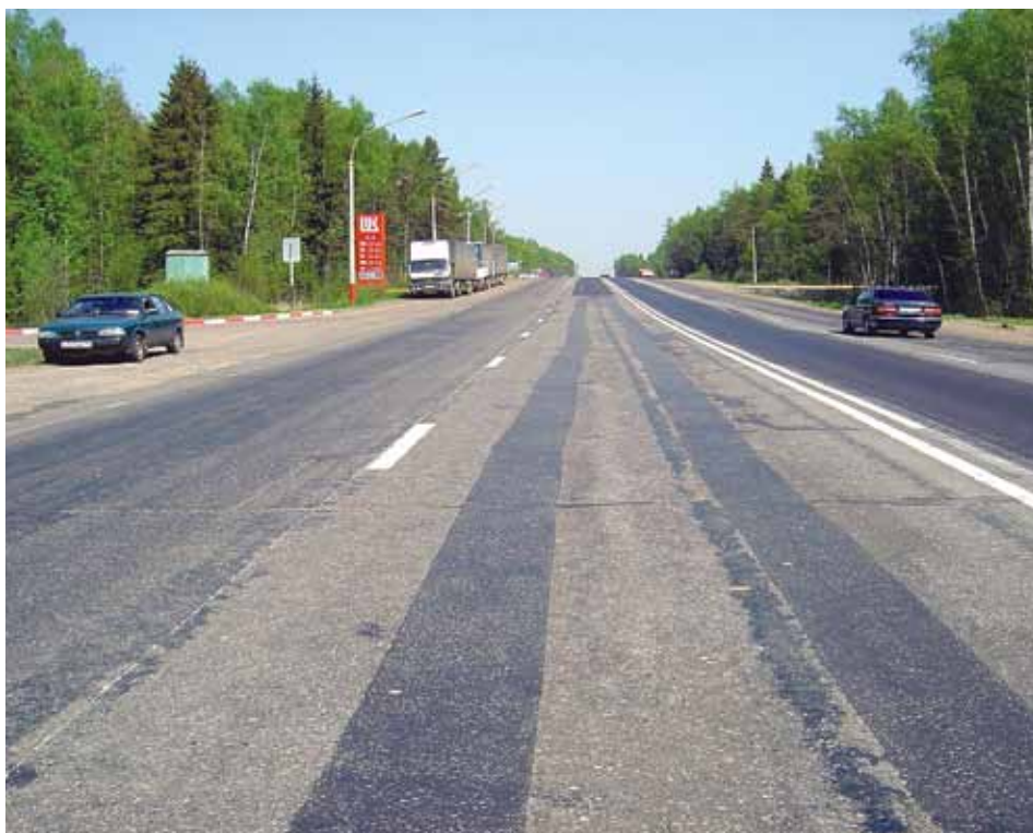
Фото 7. Колея, отремонтированная литым асфальтобетоном (справа – готовая полоса движения)
