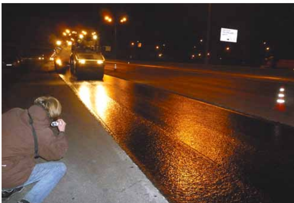
Фото 4. Устройство нижнего слоя из вибролитой асфальтобетонной смеси марки ВЛА-20 толщиной 50 мм (Москва, 86–87 км МКАД, декабрь 2010. Температура воздуха: –6°C)
