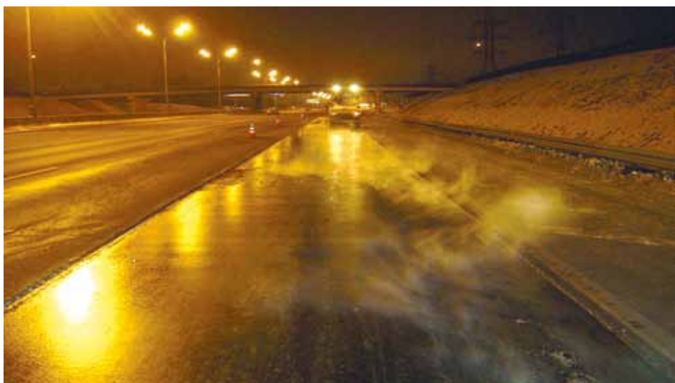
Фото 5. Устройство нижнего слоя из вибролитой асфальтобетонной смеси марки ВЛА-20 толщиной 50 мм (Москва, 86–87 км МКАД, декабрь 2010. Температура воздуха: –14°C)
